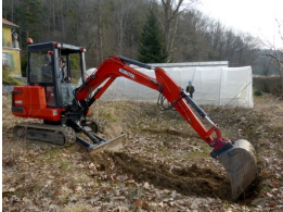
Abb. 1: Ausheben des Teichs mit Kleinbagger
