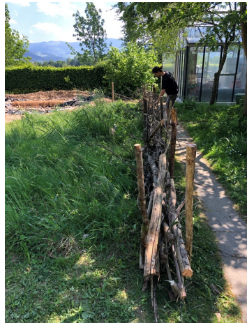
Abb. 1: Die Pfosten stehen und können nun aufgefüllt werden.
